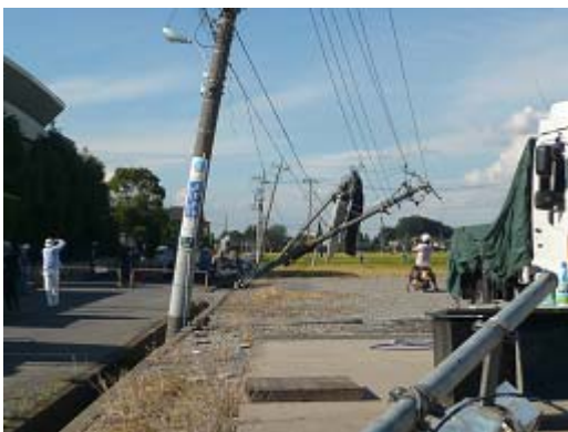
■ 写真1 電柱の転倒
